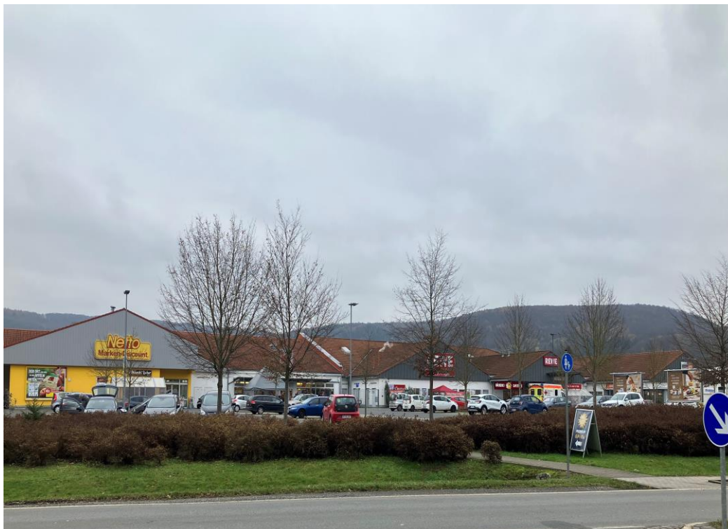
Ansicht der gesamten Anlage
